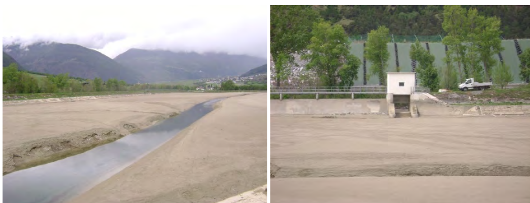
Figura 5.14: La canaletta centrale formatasi in seguito alla svaso ed immagine dello scarico nel Fiume Adige
