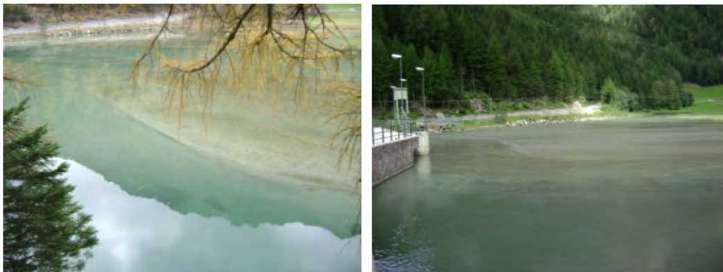
Figura 5.16: Due immagini che testimoniano l'avanzato stato di interrimento del bacino
