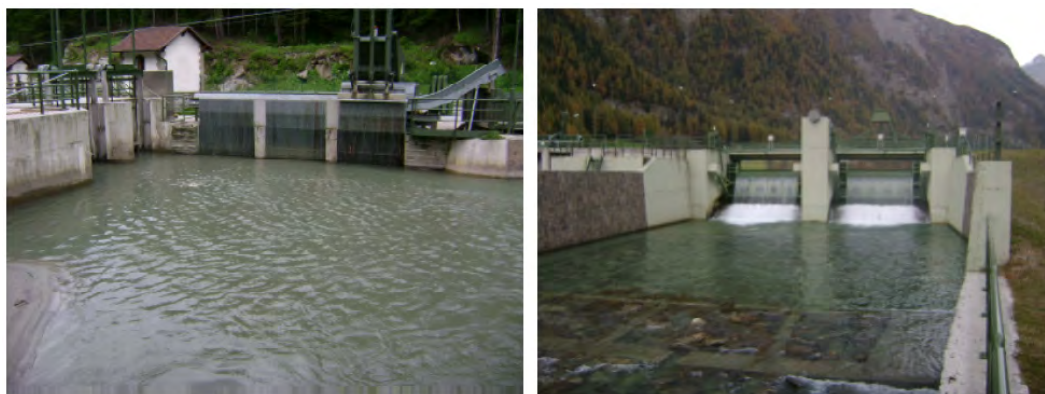
Figura 5.15: Paratoie a settore e bocche di presa di Novale
