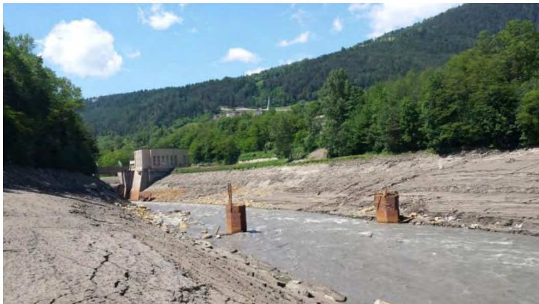
Figura 6.72: Vista verso valle (verso la diga) del bacino di Rio di Pusteria durante la fase finale delle operazioni di flushing. Si nota il notevole asporto del materiale fine
