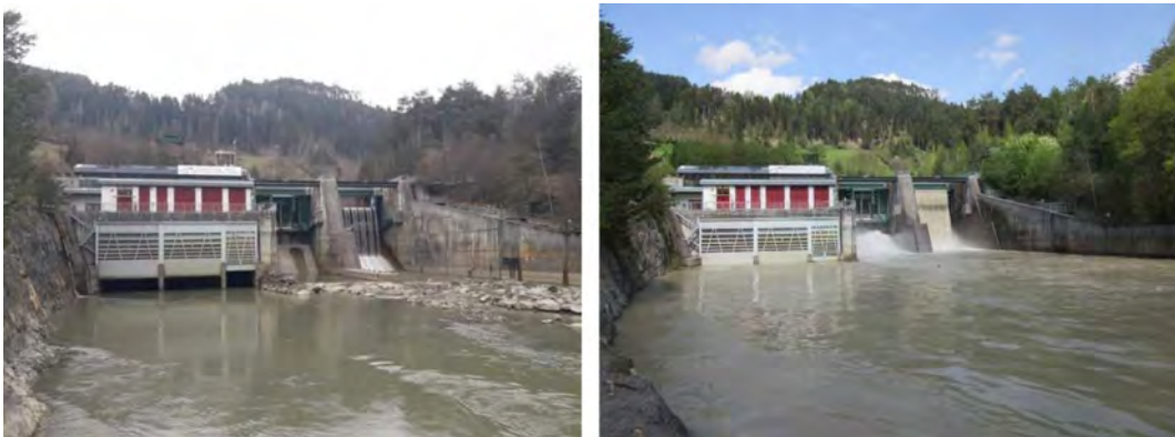
Figura 6.9: Lo sbarramento visto da valle, in condizioni di derivazione (sx) ed in sfioro (dx)
