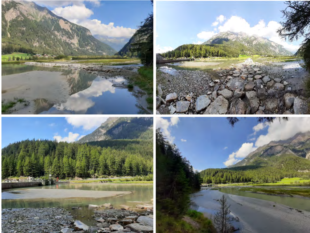
Figura 5.19: L’interdiga ed il serbatoio sul Rio Vizze a Novale
