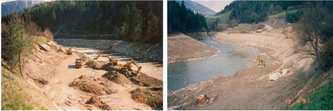
Figura 6.5: I lavori di stabilizzazione delle sponde del bacino di rigurgito nel 1991 (fonte: Azienda Servizi Municipalizzati di Brunico)
