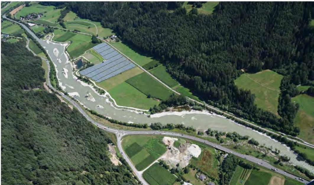
Figura 6.35: Immagine aerea dell'allargamento "Ilstener Au" al termine dei lavori (fonte: Agenzia per la Protezione Civile)
