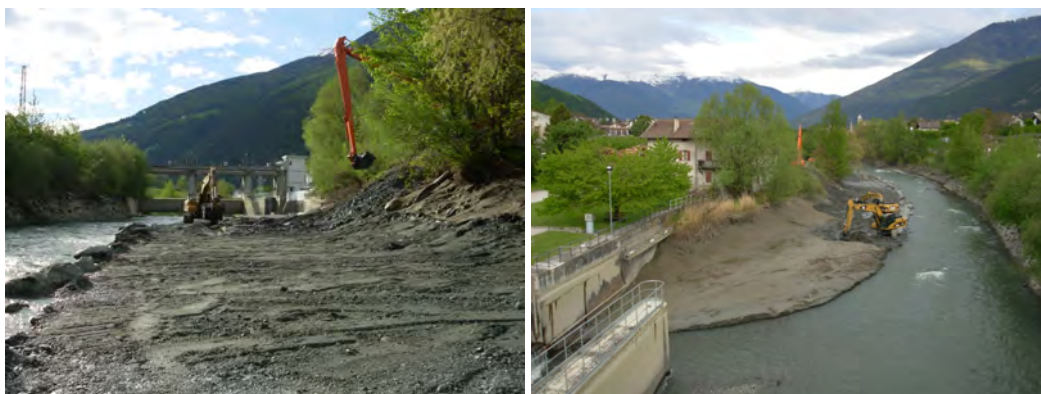
Figura 5.10: Le operazioni di rimozione meccanica del 2010 presso la traversa di Lasa
